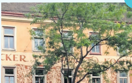
LÖSUNG: Fassade „Bäckerei Schrott“, 15., Mariahilfer Straße 159
